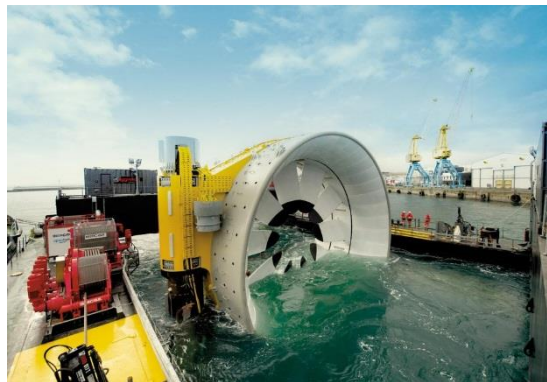
Figure I-1. Phase de maintenance sur une hydrolienne
