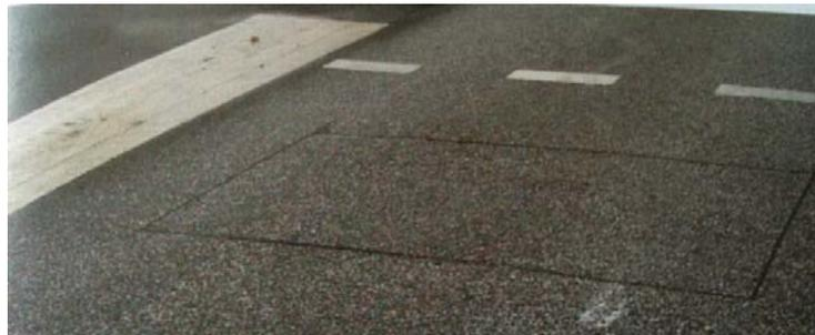
Figure 2. 14 : Boucle magnétique intégrée dans le sol
