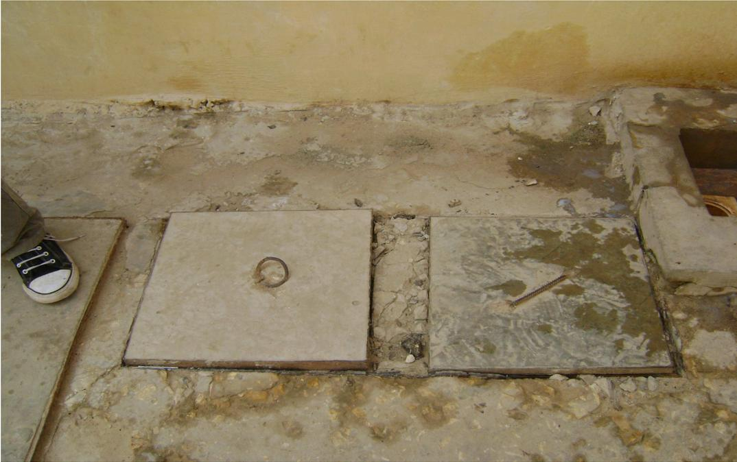
**Photo11 : Exemple de dégraisseurs à Castor, Arafat et Diokoul.**
