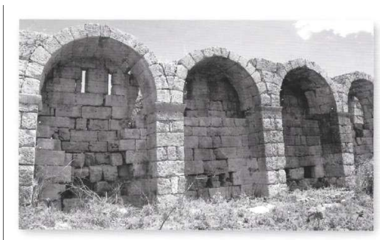
Figure 14 – SECTEUR DE L'ENCEINTE DE PERGE
