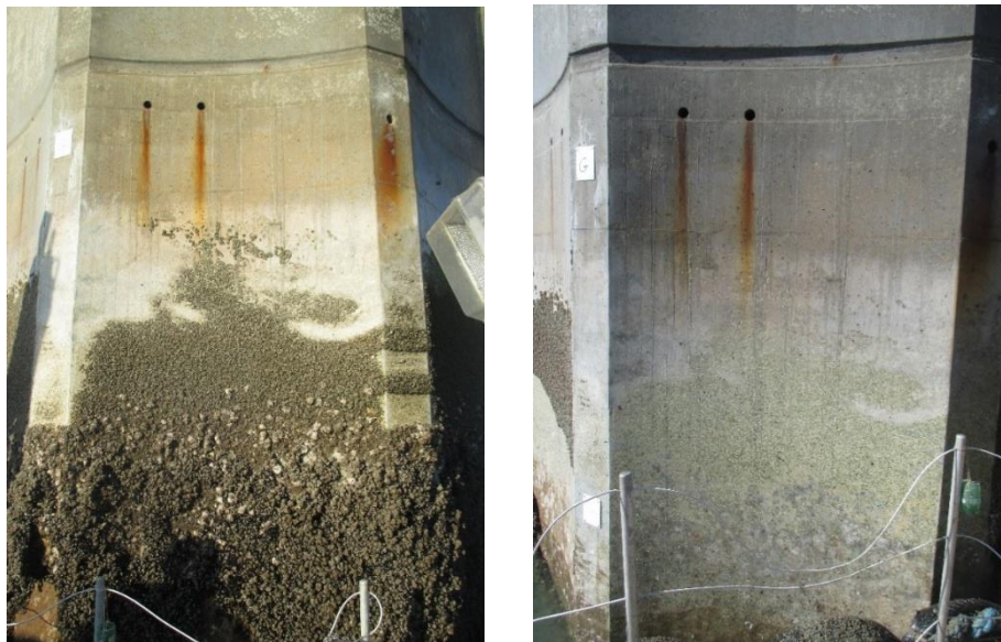
Figure 2-13 : Face de pile PG-FG avant (à gauche) et après (à droite) l'opération de nettoyage.
