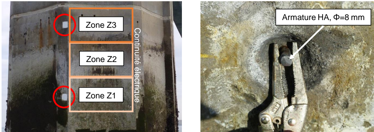
Figure 2-19: Photographies des connexions permanentes de la face de pile PE-FG.
