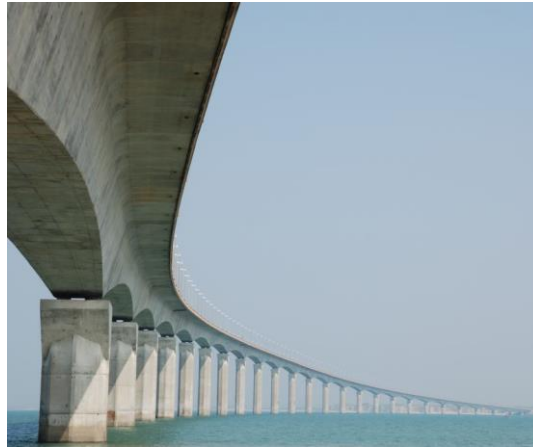
Figure 2-1 : Photographie du pont de l'île de Ré (Crédit photographie : V. Bouteiller, 2015).
