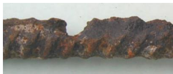
Figure 1-8 : Piqures de corrosion dues à la pénétration des ions chlorure [Dooms 2008].
