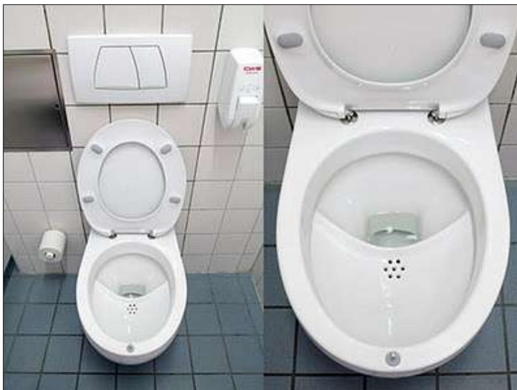
Figure 11 : Photos du système « NoMix » conçu pour la séparation des urines et excréments, afin de faciliter le retraitement des eaux usées<sup>75</sup>
