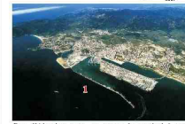
Port d'Algeciras avec, au centre, le terminal à conteneurs. Dic. SW. Vue aérienne oblique Tecdiglo, 2001.
