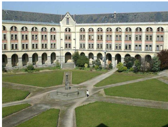
Photo n°2 : Cour centrale de la prison 60
