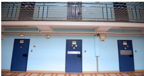
Photo n°4 : Portes de cellules 63
