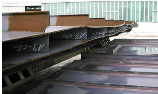
Figure I-18 : Panneaux plans et raidisseurs soudés par soudage sous flux. Notez les déformations causés par le soudage [44]
