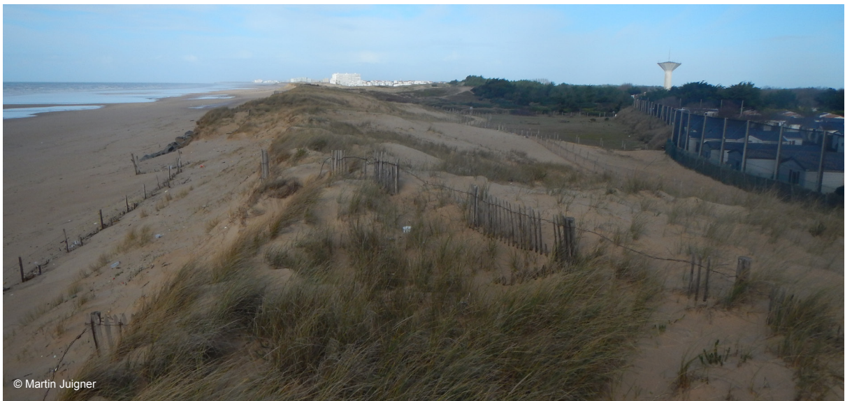
Figure 5 : Exemple de cordon dunaire jouant un rôle de protection face à la submersion marine. Une partie du camping (à droite) est située sous la cote de l'aléa de référence (02 février 2014, La Pège, Saint-Hilaire-de-Riez, Vendée).
