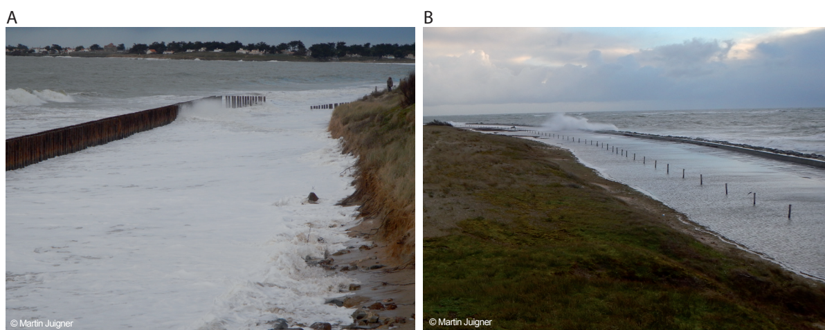
Figure 1 : A- recul du trait de côte et B- submersion par franchissement de paquets de mer à la Pointe du Devin, Ile de Noirmoutier (Vendée), le 01 février 2014 (coefficient de marée 114).
