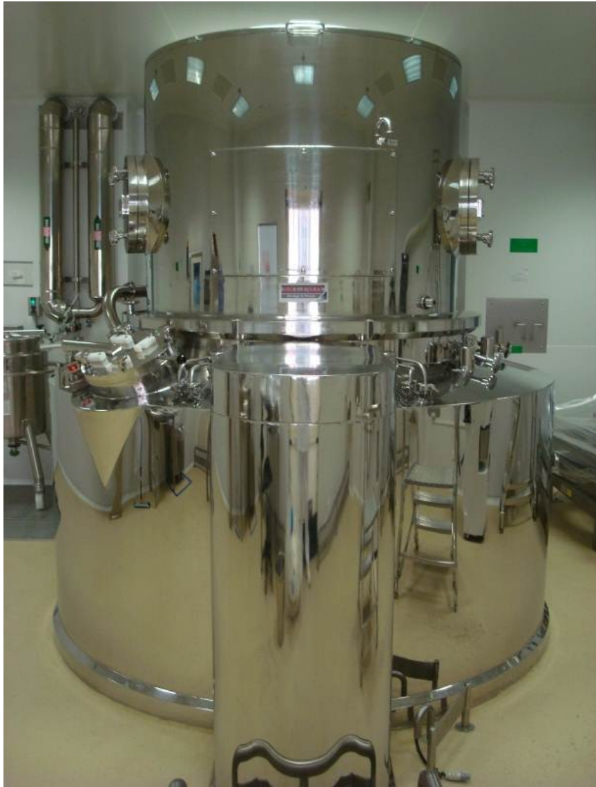
Figure 9 : Mélangeur-Granulateur-Sécheur de 2000L présent chez Servier
