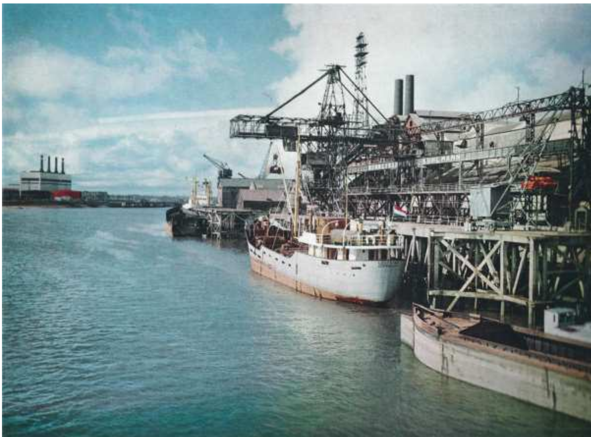
Fig. 39. Appontement de l'usine des Etablissements Kuhlmann à Chantenay dans les années 1950.
