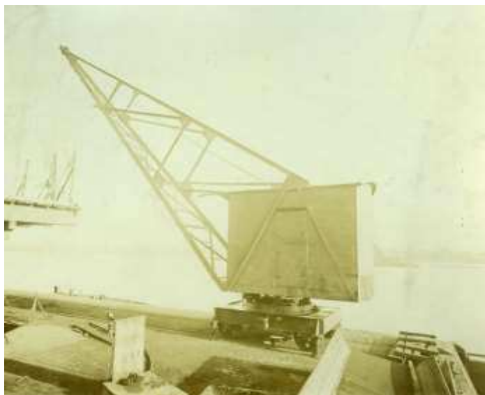
Fig. 40. Grue électrique de quai en 1906.
