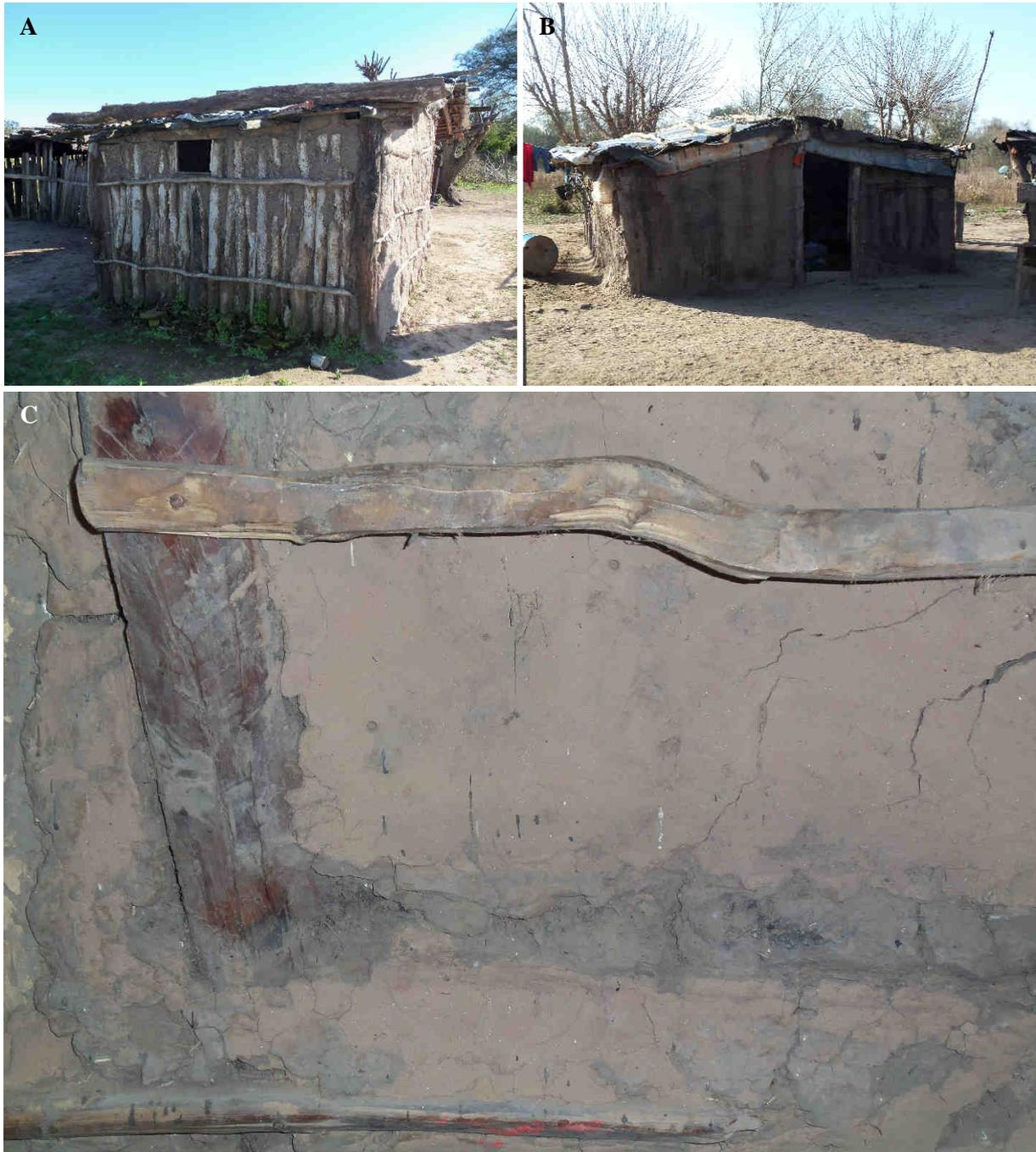
**Figure 43** : Les ranchos, des conditions idéales de nidification pour les triatomés [Collection personnelle]. (A et B) Ranchos en bois et boue séchée, avec des toits en tôles de métal. (C) Murs tâchés par des excréments de triatomés à l'intérieur de l'habitation, et fissures permettant au vecteur de se cacher et d'établir une colonie intradomiciliaire.
