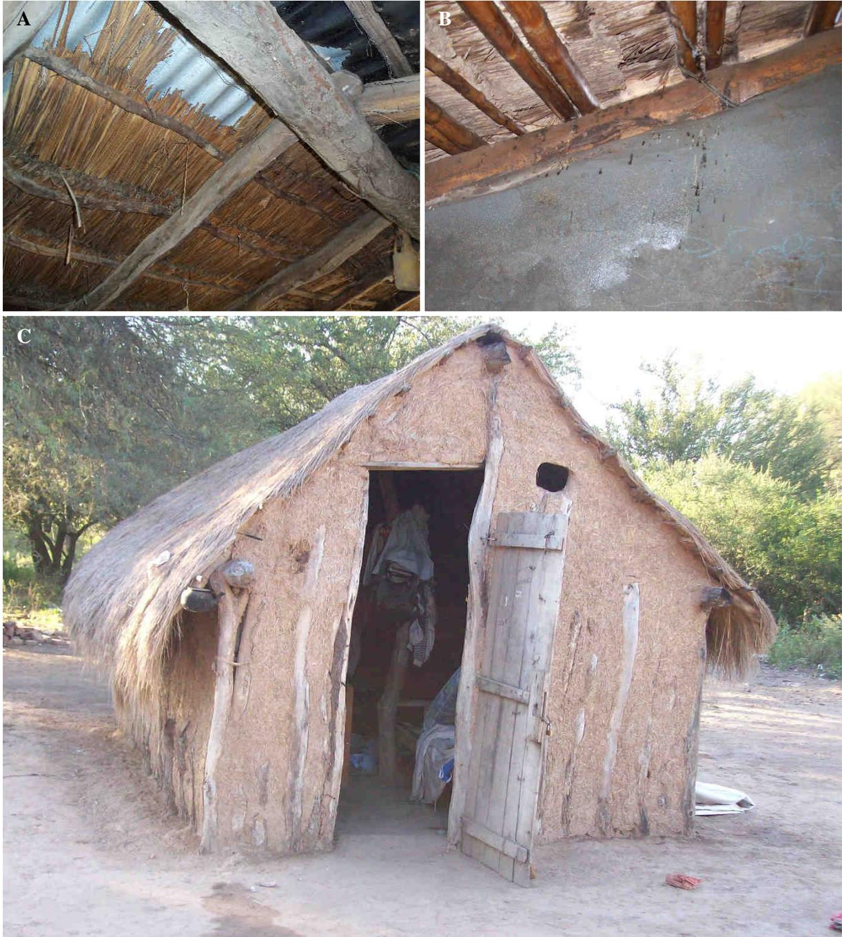
**Figure 44** : Ranchos avec des toits constitués de paille [Collection personnelle]. (A) Toit d'un rancho partiellement constitué de paille sous la tôle en métal. (B) Tâches de déjections de triatomés remontant vers un toit en paille. (C) Rancho avec un toit entièrement en paille.
