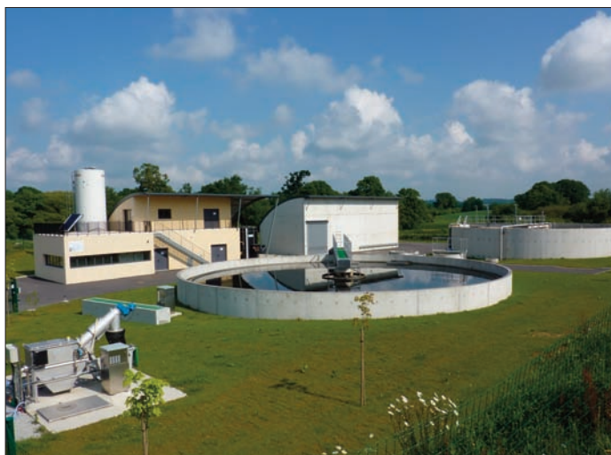
Photo 15. Station d'épuration à boues activées de Locqueltas
