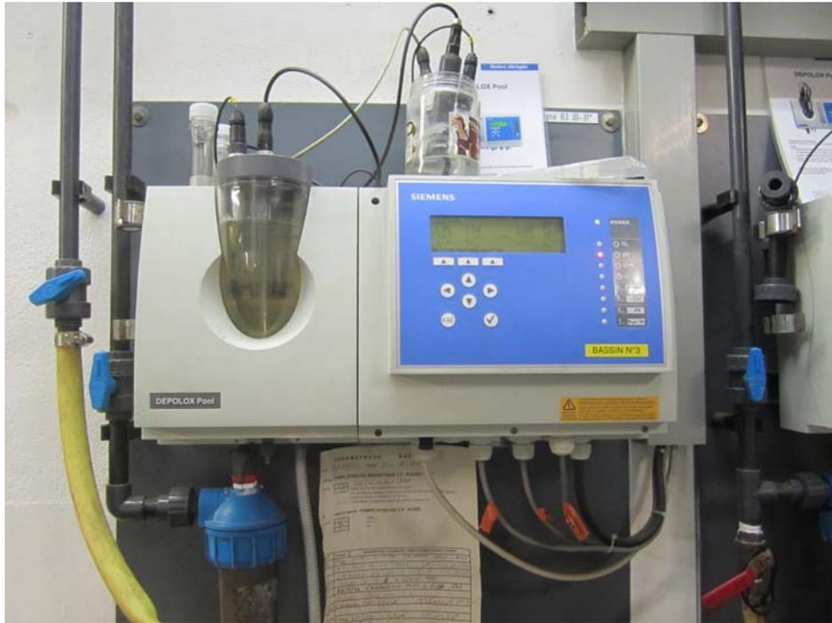
*Photo 6 : Appareil mesurant en permanence le taux de chlore libre totale, le Ph et la température de l'eau du bassin auquel il est relié.*
