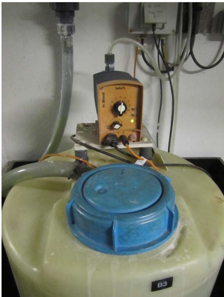
*Photo 5 : Cuve contenant de l'eau de Javel, à laquelle est fixée une pompe injectant la quantité demandée dans l'eau filtrée.*
