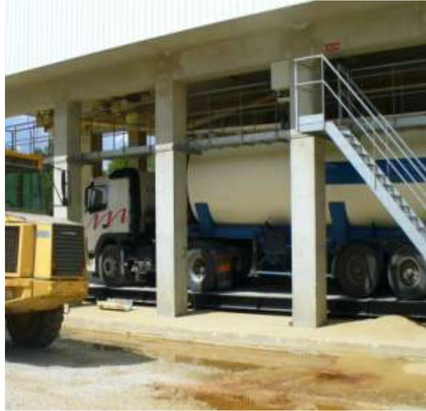
**Photo 11 : chargement des camions citernes. Installation de ponts bascules au sol pour pesage instantané ;**
