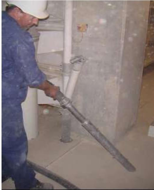
**Photo 14:** installation d'un système d'aspiration pour le nettoyage, évitant la remise en suspension des poussières de sable.
