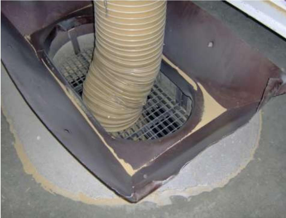
**Photo 16 : le sable est stocké dans un silo sous terrain, le déversement s'effectue par une trémie grillagée . le risque d'émission de poussière est fortement diminué ;**
