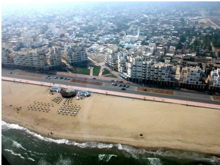
Figure III. 18 – Vue aérienne de la plage de Martil.
