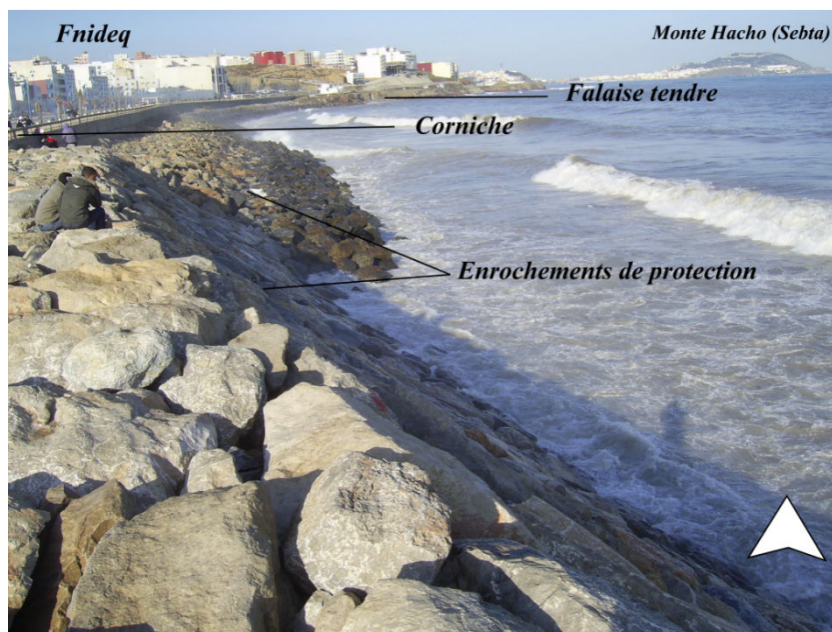
Figure III. 78 – Enrochements pour la protection de la corniche de Fnideq (cliché : 27/11/2007).
