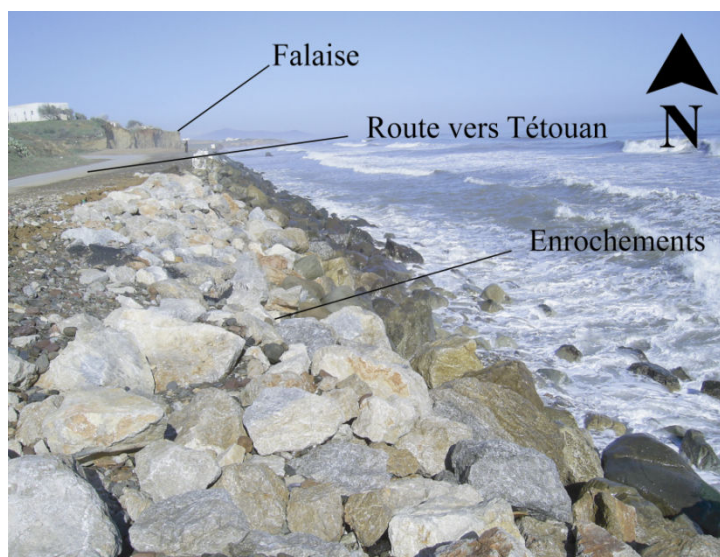
Figure III. 60 – Enrochement au nord d’Azla en vue de protection de la route vers Tétouan (27 / 11 / 2007).
