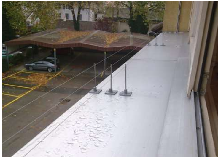
Figure 22 : fil tendu installé sur le rebord d'une fenêtre (22)
