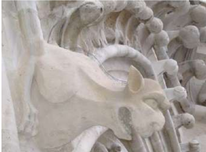
Figure 25 : gargouille équipée du système d'électro-répulsion (Broussois, 2005)
