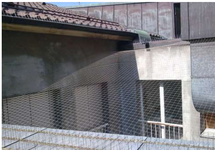
Figure 23 : filet interdisant l'accès à une cour intérieure (22)
