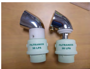
Figure 18. Filtres anti-légionelle fixés sur douches fixes
