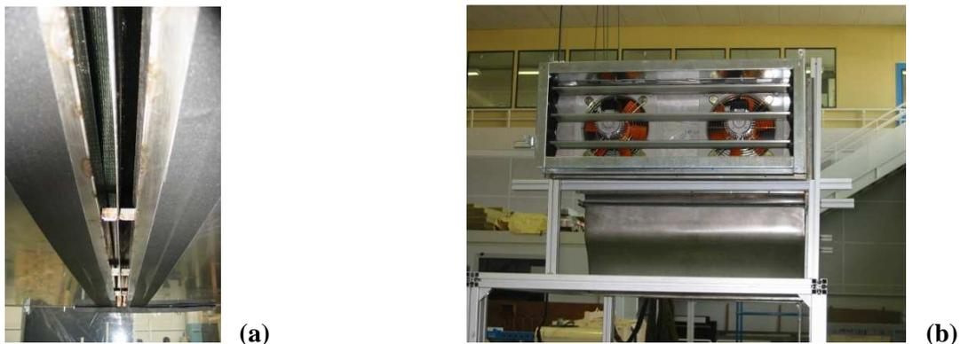
Figure 2.40 : dispositif de soufflage ; a) buse de soufflage; b) ventilateur hélicoïdal équipé d'un registre 3 lames
