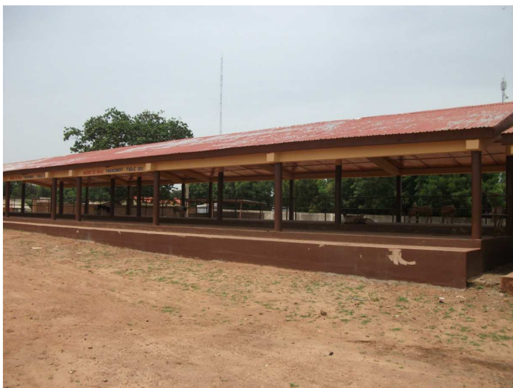
Photo 5: Une des tribunes construites place Gaani par le Ministère de la Culture ; le modèle a été repris place Gaani par la Mairie. Le sol a été compacté en matériaux locaux pour faciliter la cavalcade (Photo P. Akogni)
