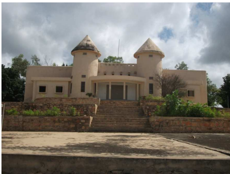
Photo 54: Résidence du Préfet de l'Atacora, résidence construite par les colons français en 1949 (Photo P. Akogni)
