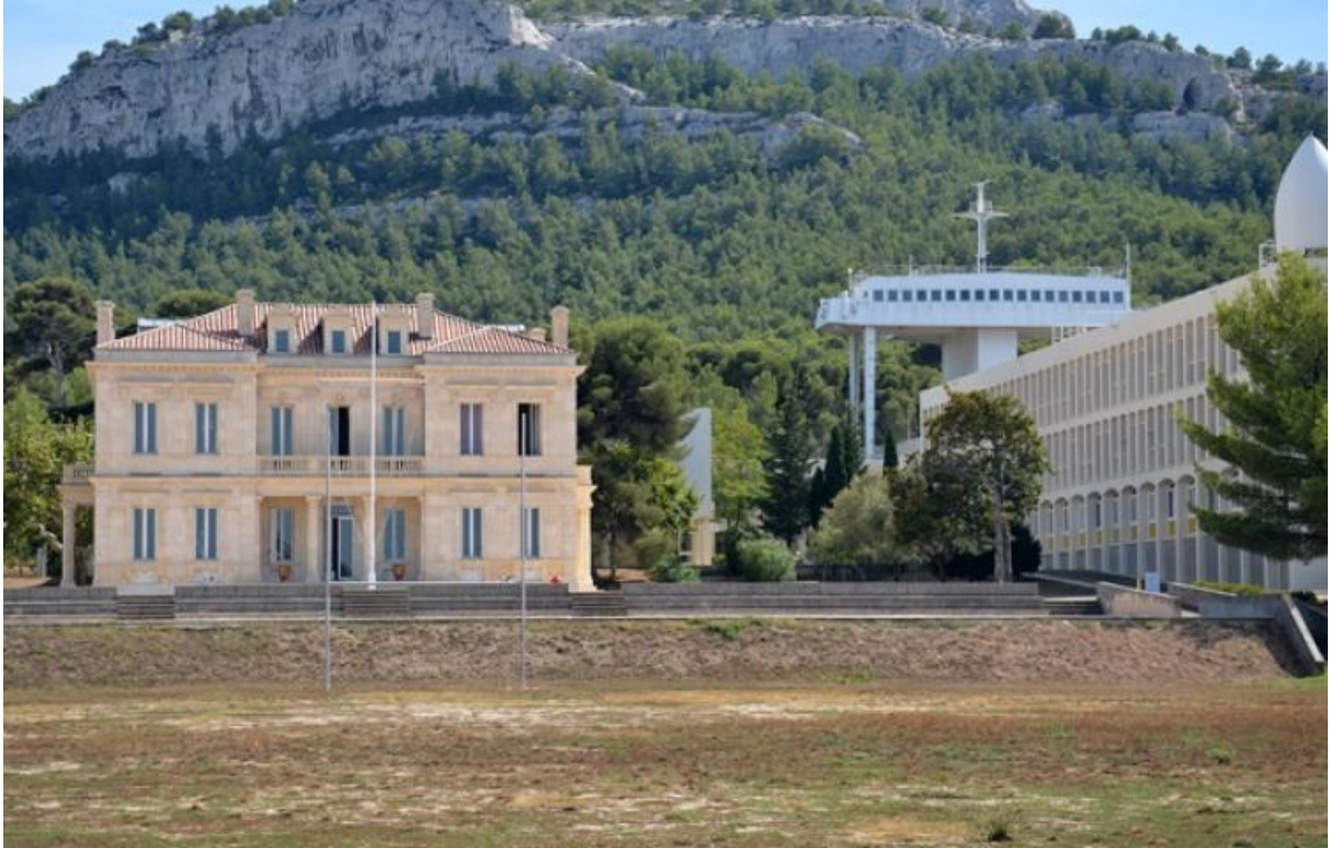
Figure 24 - ENMM de Marseille - Le bâtiment de la direction, la cour d'honneur et le mât des couleurs, la passerelle de navigation, le bâtiment de cours et l'ancien internat. Source : Service de communication de l'ENSM, circa 2015.
