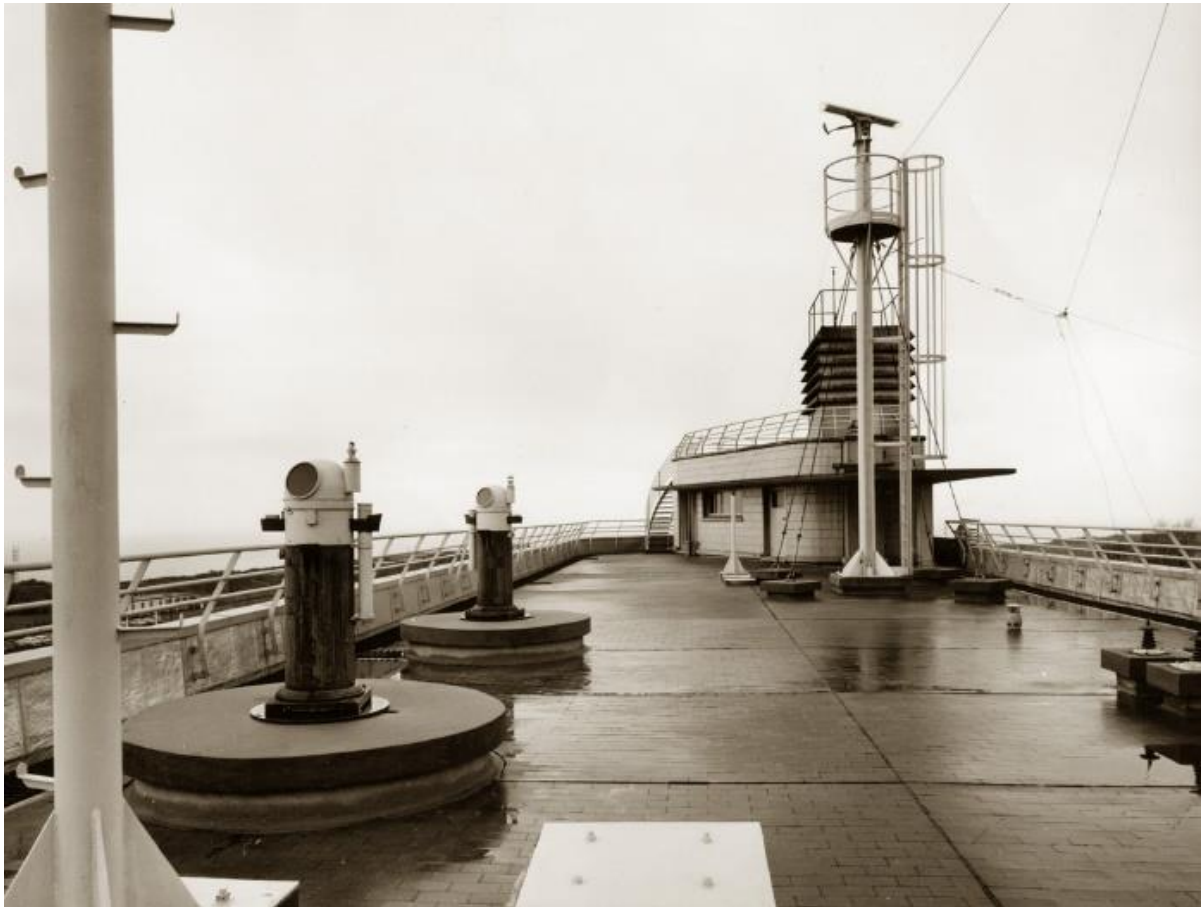
Figure 23 - Passerelle de navigation et d'observation astronomique de l'ENMM de Sainte-Adresse. Au premier plan compas magnétiques, au deuxième plan mât et antenne radar, antenne radio filaire. 1967- Source : www.Memoiredelhydro.org
