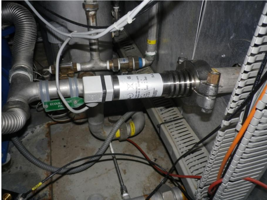
**Figure 12: Capteur de pression**
