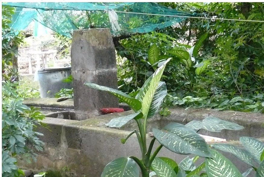
b. vue de la partie gauche avec l'arrivée d'eau
