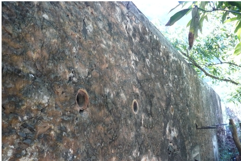
b. vue du mur arrière à l'ouest
