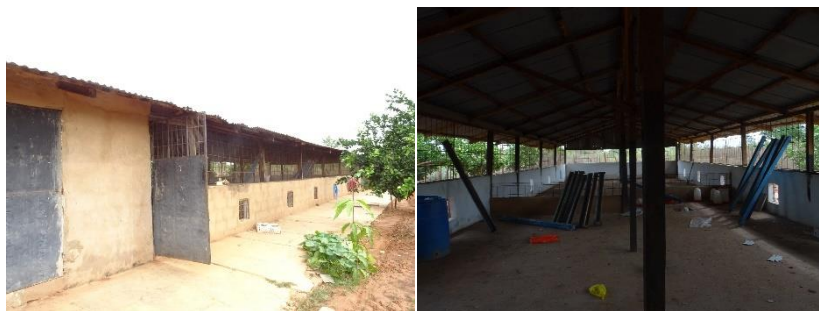
Planche 23 : Bâtiment avicole dans la ferme d'un aviculteur relocalisé à Djilakoune
