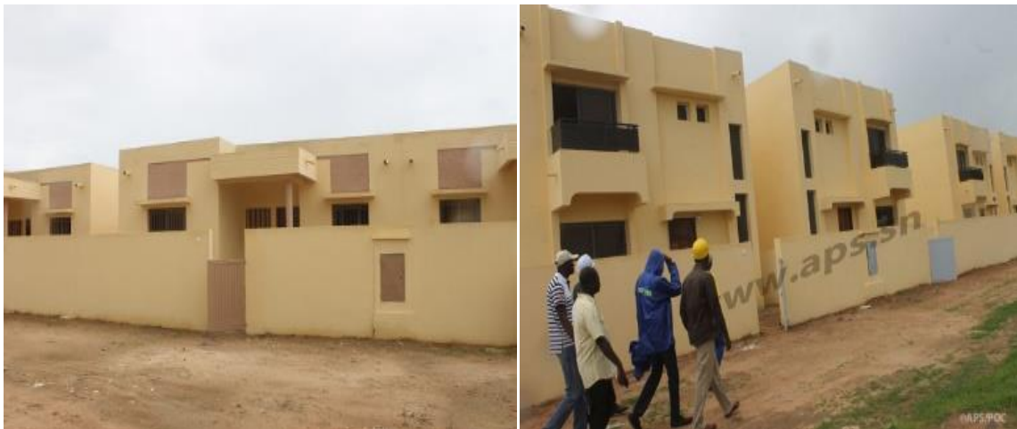
Planche 26 : Construction d'unités d'habitation dans le quartier Kenya. Source : APS, 2017
