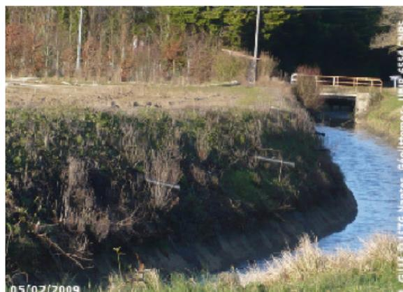
**Photographie B-3 : Drains souterrains d'une parcelle, se déversant dans le canal d'amenée, Machecoul (44)**
