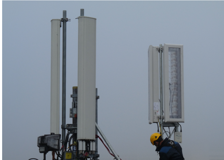
FIGURE 1.32 : Site sur la terrasse de l'agence de Bouygues Telecom à Nantes avec deux antennes classiques à gauche et deux antennes transparentes fabriquées par RFS Lannion à droite
