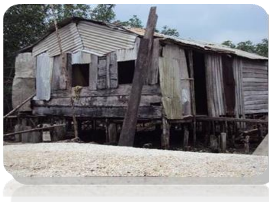
Bâti en planche et tôle sur pilotis
