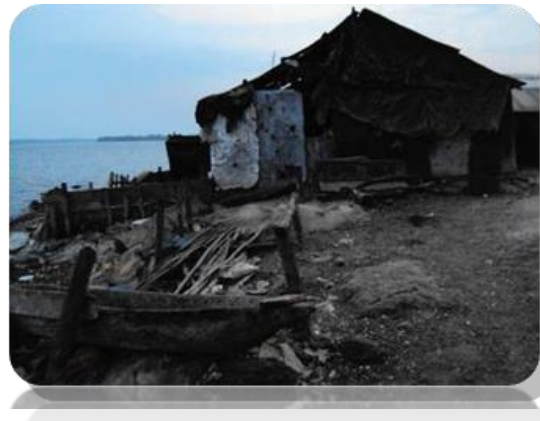
Bâti en bâche , tôle et planches
