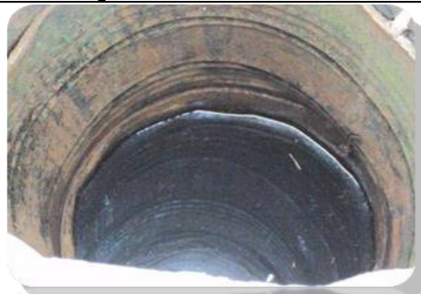
Puits creusé à Limbé
