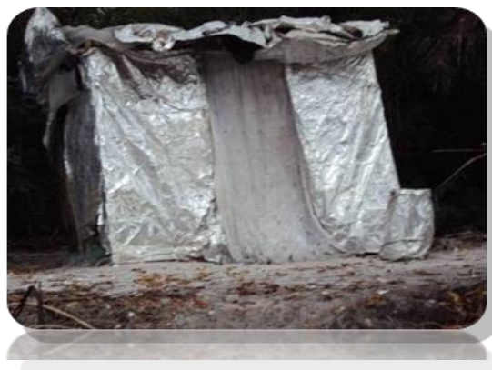
Bâti en tôle
