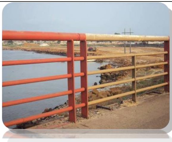
Aperçu d'un bulldozer au fond, achevant le déblayage du campement de Pont Nomba.
