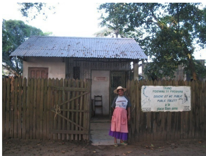
Photo 18: Bloc douche WC à Ampasimazava (avril 2007)
