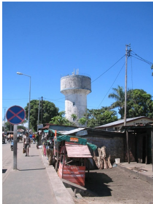
Photo 6 : Le château d'eau de Tanambao II (mars 2007)
