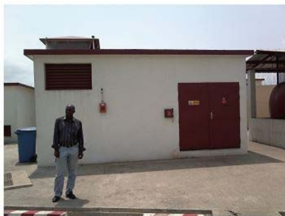
Photo n°7.1 : Une vue du local abritant un groupe électrogène au port d'Owendo au Gabon
