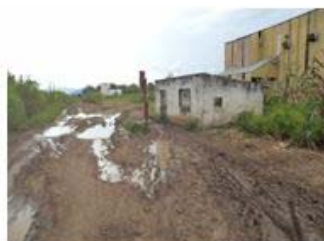
Photo n°1.1: Une vue de la voie d'accès dégradée de la SODERIM
