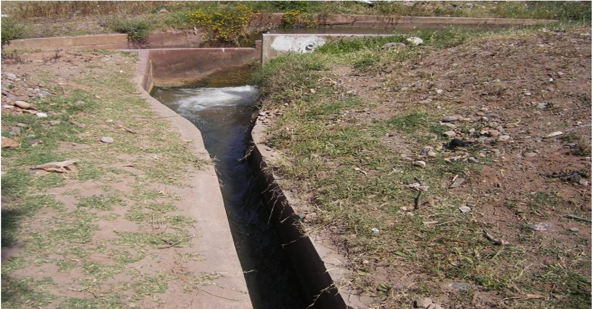
Figure 8: Photo d'une canalisation à ciel ouvert (Seguia) servant de distribution des eaux de l'Oued Tensift sur les sols agricoles de la zone étudiée.
