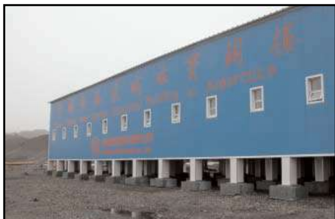
Station Great Wall (Chine) – Bâtiments récents abritant les générateurs (2005).
