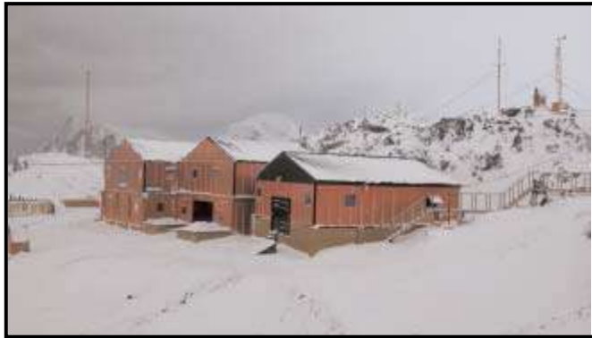
Station San Martin (Argentine) – Bâtiments principaux.
