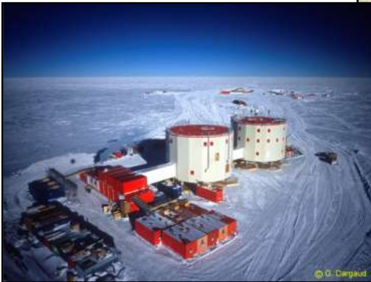
Station Concordia (France-Italie) – Vue aérienne de la station.
