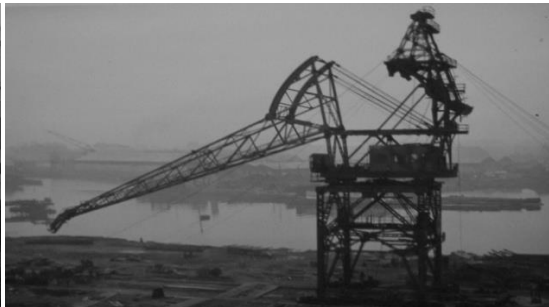
Photo 37 : Mise en place de la partie tournante de la grue Applevage
