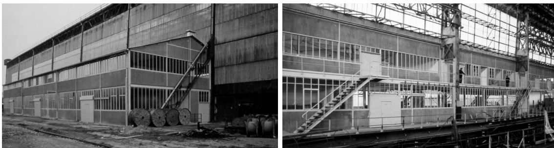
Photo 39 : Bureaux et magasins le long-pan nord de la forme (extérieur à droite, intérieur à gauche)
