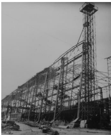
Photo 1 : Cale n° 7 dévastée par les bombardements
