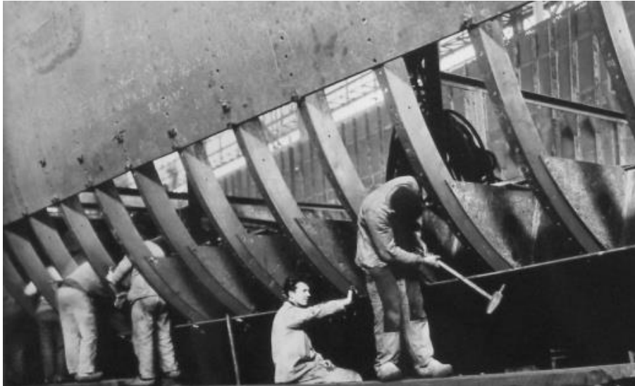
Photo 15 : Boulonnage de la muraille
