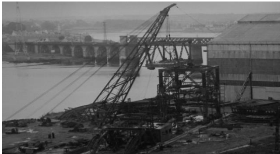
Photo 37 : Mise en place de la partie tournante de la grue Applevage
