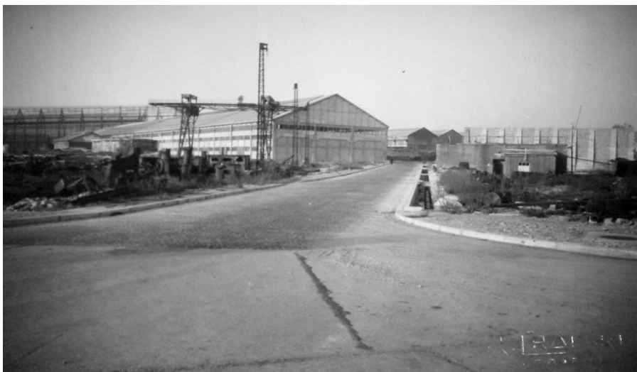
Photo 24 : 1949, déviation de la route de l'Arsenal joignant le pont de Gueydon à la Place Maupéou
