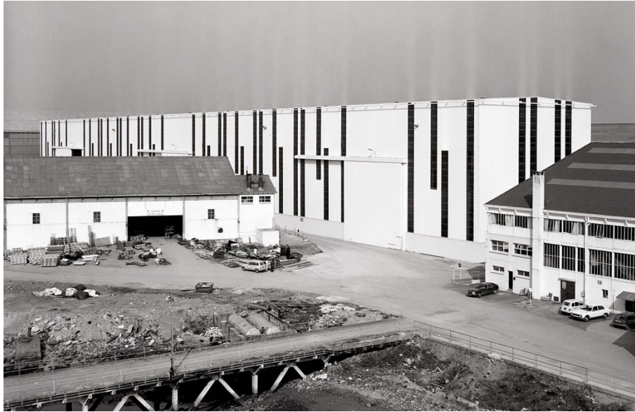
Photo 41 : Hall de préfabrication achevé
