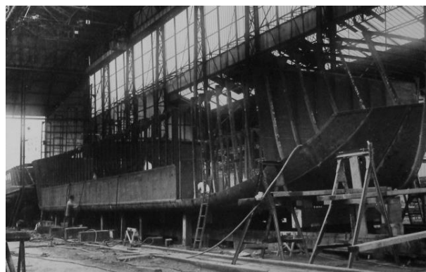
Photo 5 : Gabarre en construction dans la cale par la méthode traditionnelle
