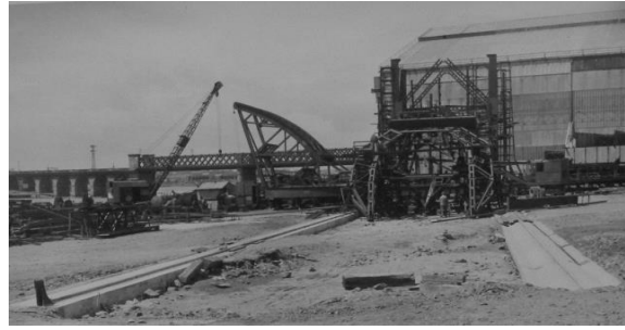
Photo 36 : Construction d'un chemin de roulement pour la grue Applevage
