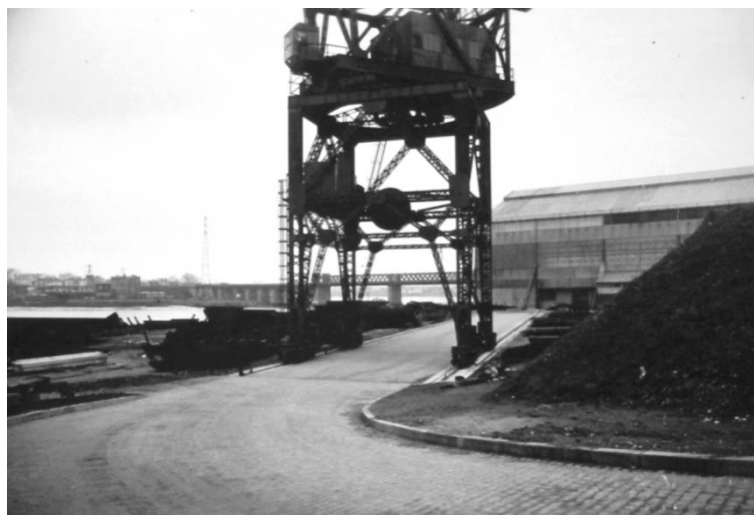
Photo 38 : Empierrément entre les rails de la grue Applevage
