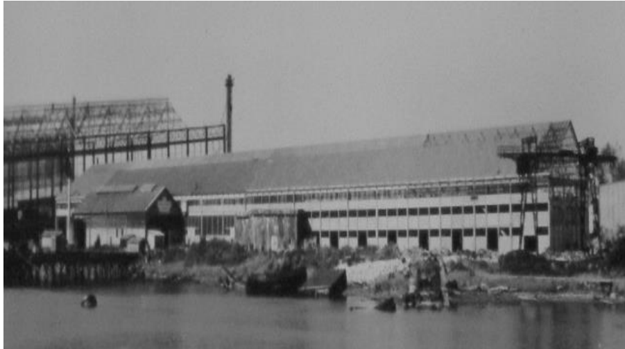
Photo 23 : Travaux d'agrandissement de la salle à tracer
