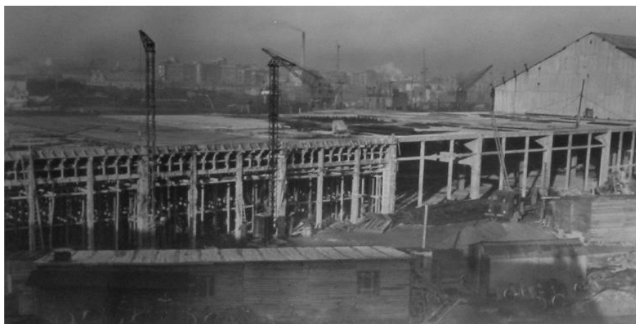
Photo 22 : Travaux d'agrandissement de la salle à tracer
