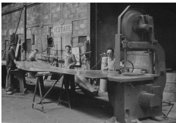
Photo 19 : Découpe à la scie à ruban d'une tôle en alliage léger
