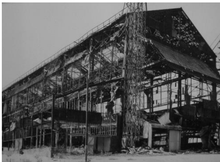
Photo 2 : Cale n° 5 en partie détruite
