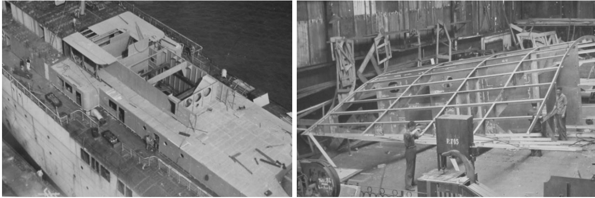
Photo 17 : Superstructure et cheminée du paquebot Ville-de-Tunis construites en alliage d'aluminium
