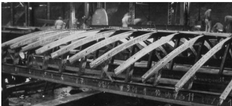
Photo 13 : Membrures et lisses formant un treillis d'un panneau de muraille maintenue horizontalement pour former une table de soudure
