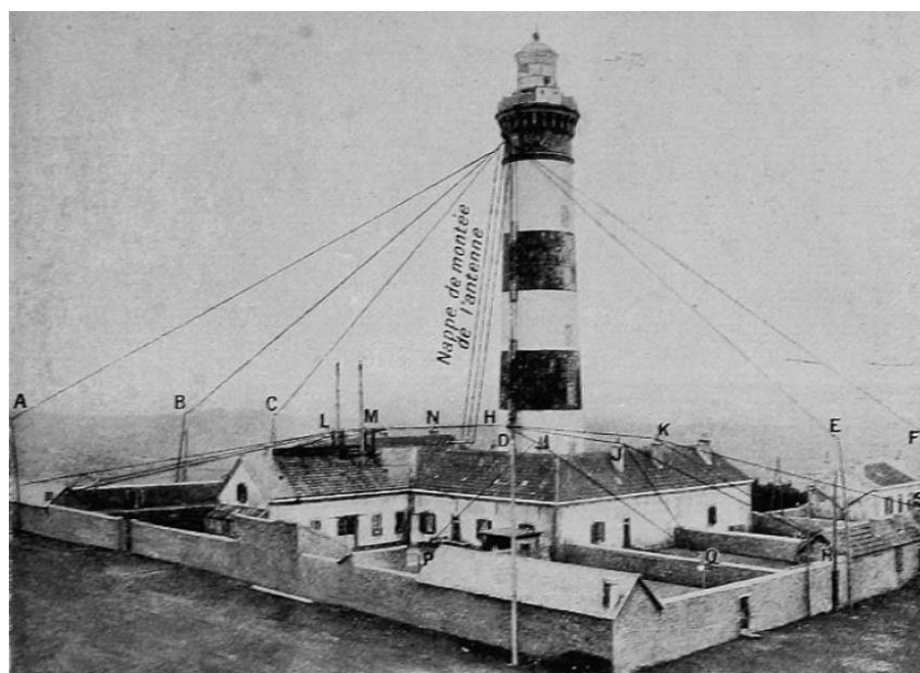
Figure 82 : Antenne du radiophare d'Ouessant en 1912. 872
