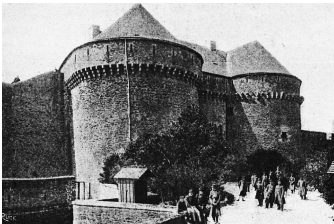
Figure 124 : Porte du château de Brest au début du XX e siècle. 1228
