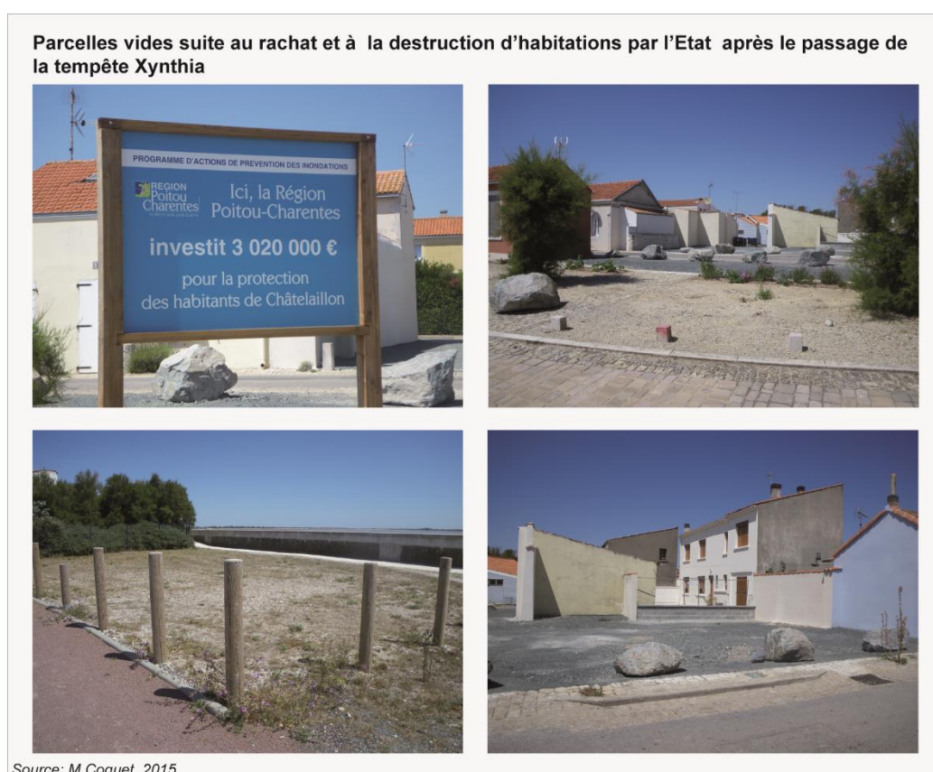
Figure 1.12 : Parcelles vides suite au rachat puis à la destruction d'habitations par l'État après le passage de la tempête de Xynthia, quartier des Bouchôleurs. Source : M. Coquet, 2015.
