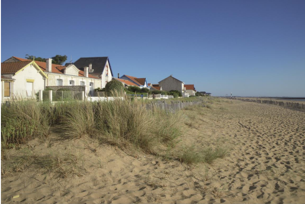
Figure 1.11 : Vue depuis la plage au sud de la commune. Dans ce secteur, les habitations sont construites directement sur un petit massif dunaire et se trouvent en zones fortement exposées aux submersions marines selon le scénario de référence du PPRL (ARTELIA pour la DDTM 17, 2017). Source : M. Coquet, 2015.
