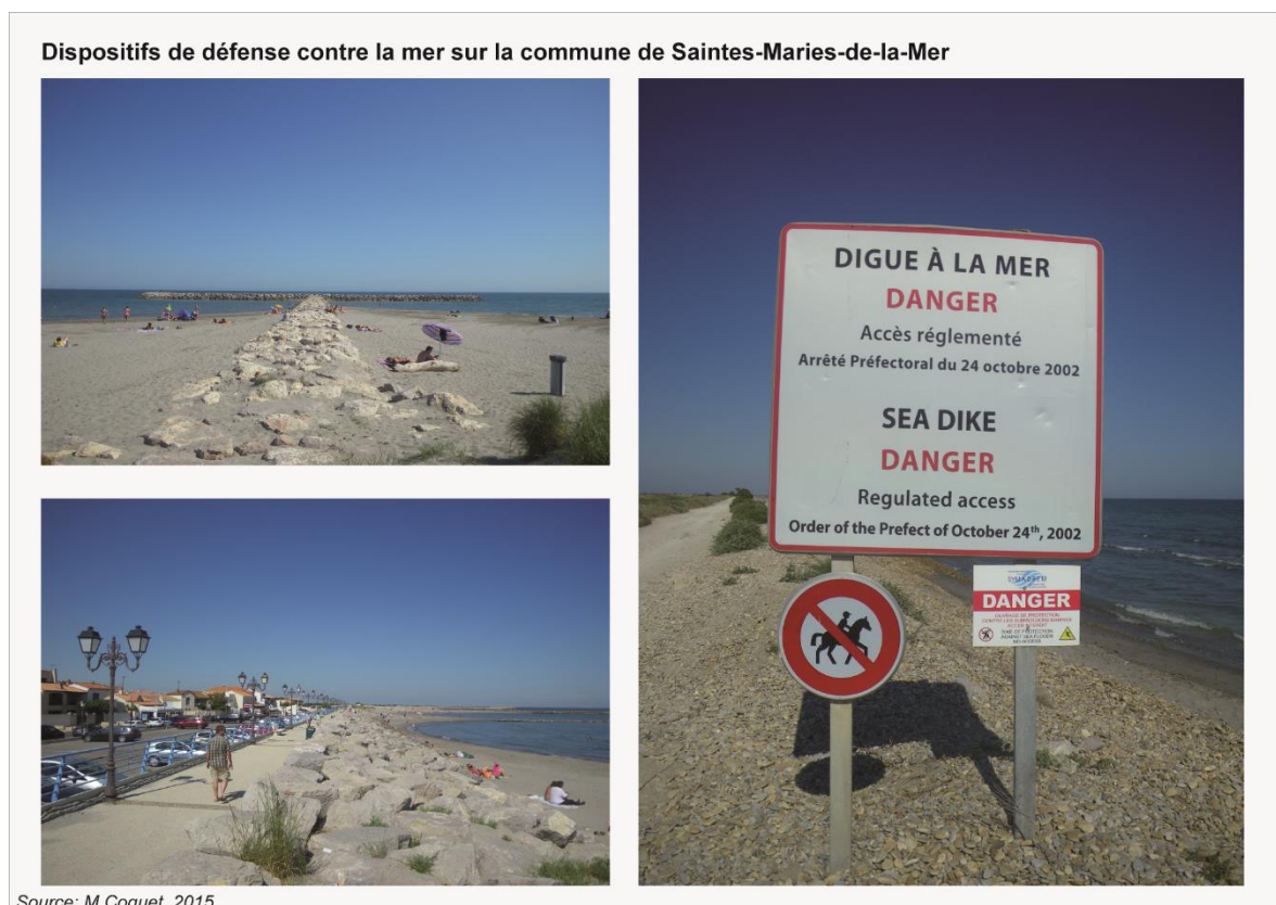
Figure 1.8 : Exemple de dispositifs de défense présents sur la commune des Saintes-Maries-de-la-Mer, en haut à gauche : brise-lame, en bas à gauche : digue avec enrochement, à droite : digue. Source : M. Coquet, 2015.
