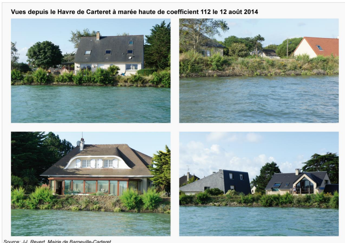
Figure 1.4 : Vues depuis le Havre de Barneville-Carteret vers le quartier de Barneville-Plage le 12 août 2014 lors d'une marée haute de coefficient 112. Situées à l'arrière d'une digue, ces habitations sont fortement exposées aux submersions marines. Source : J-L Revert, Mairie de Barneville-Carteret, 2014.
